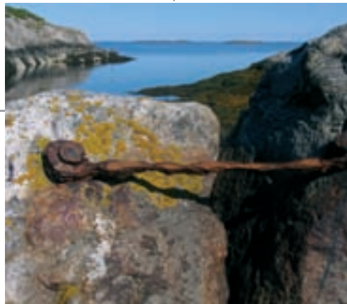
Statens kaianlegg i Indreholmen - store steiner sammenlenket med grovdimensjonerte metallstenger, boltet og klinket med slegge.
